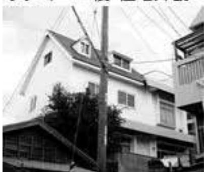
三角屋根の部分が増築した部分
