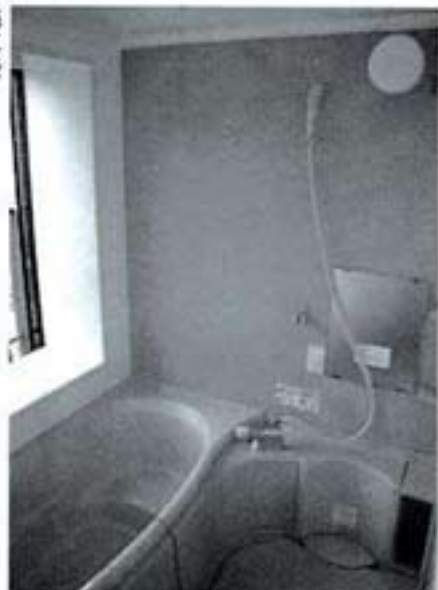
バスタブのなかった在来工法の浴室をユニットバスに変更。ユニットバスは工期が短く、パネルのカラーなど種類も豊富なのが特徴。
