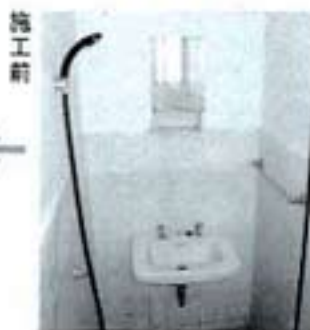
バスタブのなかった在来工法の浴室をユニットバスに変更。ユニットバスは工期が短く、パネルのカラーなど種類も豊富なのが特徴。
