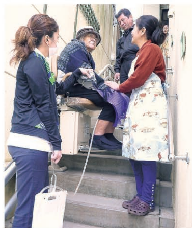
1階がピロティになっている住宅の階段に昇降機を設置。介護者と顔を合わせられ安心感もある
